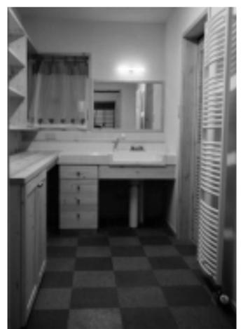
床材にコルクを使用した施工例。無塗装タイプを自然塗料で染色仕上げたユーティリティの床。
